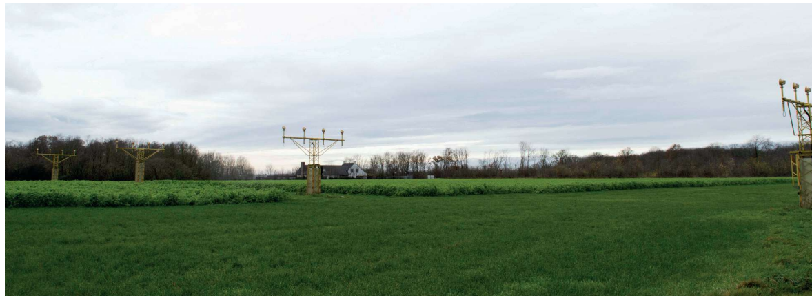
3. De aanvliegsignalen voor Maastricht-Aachen Airport staan middenin het plangebied. De omgeving van de signalen moeten vrijblijven.
