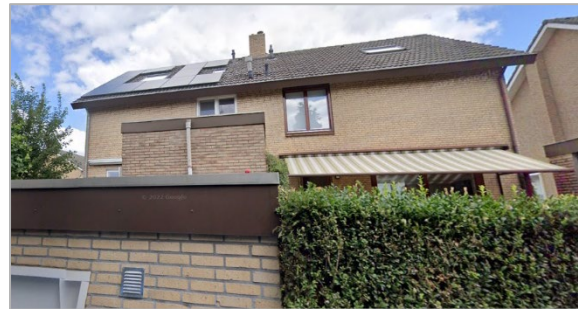
Figuur 14 Achtergevels Synagogeplantsoen 34 en 36 in goede staat van onderhoud
