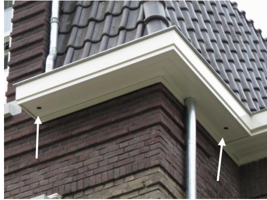
Figuur 6: Voor gierwaluw zijn nestlocaties ook in te bouwen in de gootconstructie.
