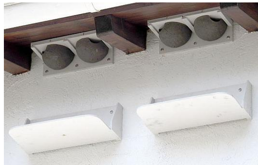
Figuur 8: Het bevestigen van een eenvoudige mestplank onder de nestkommen voorkomt overlast voor bewoners.
