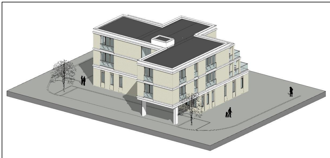
Voorgevel en linker zijgevel vanuit, gezien vanuit noordoostelijke richting
