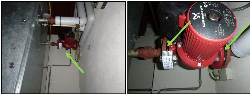
M9 – pakkingen t.p.v. pomp LBK, niet asbesthoudend.
