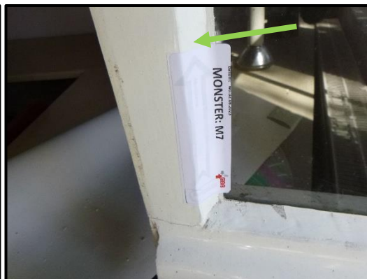
M7 – stopverf in houten gevelkozijnen, niet asbesthoudend.
