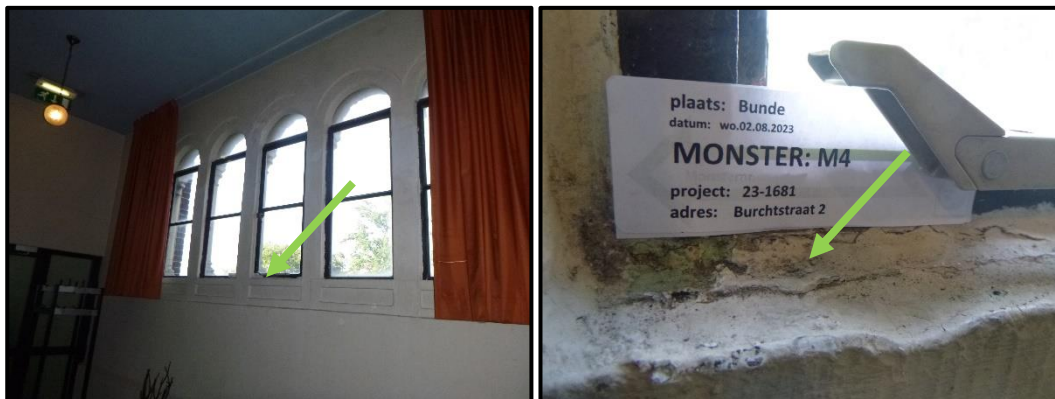
M4 – gevelkit, niet asbesthoudend.
