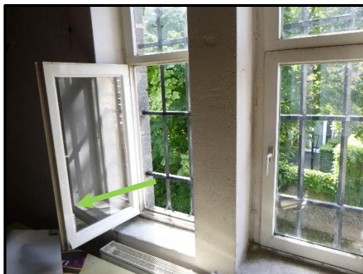
M7 – stopverf in houten gevelkozijnen, niet asbesthoudend.
