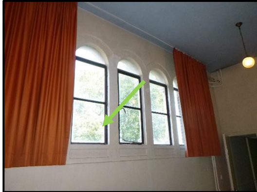
M3 – stopverf in stalen gevelkozijnen, niet asbesthoudend.
