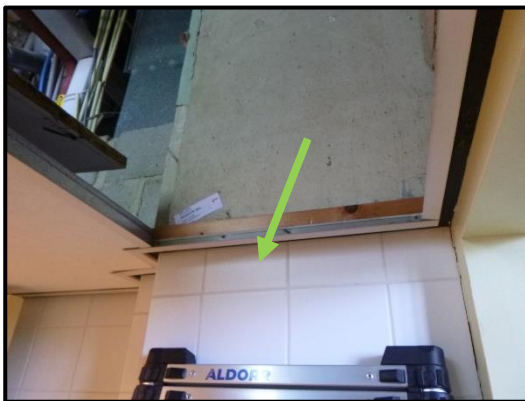
M5 – tegellijm en -voegsel wanden toiletruimte 1 e verdieping is niet asbesthoudend.
