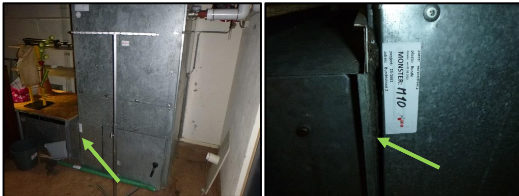
M10 – kit op luchtbehandelingskanalen, niet asbesthoudend.
