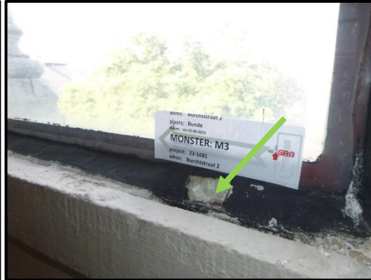
M3 – stopverf in stalen gevelkozijnen, niet asbesthoudend.
