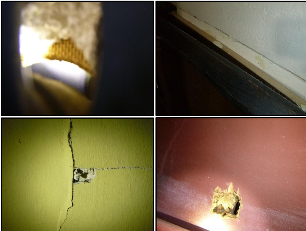
Onderzoeker heeft destructief onderzoek uitgevoerd aan vaste wand- en plafondaafwerkingen, hierbij zijn geen asbestverdachte toepassingen aangetroffen.
