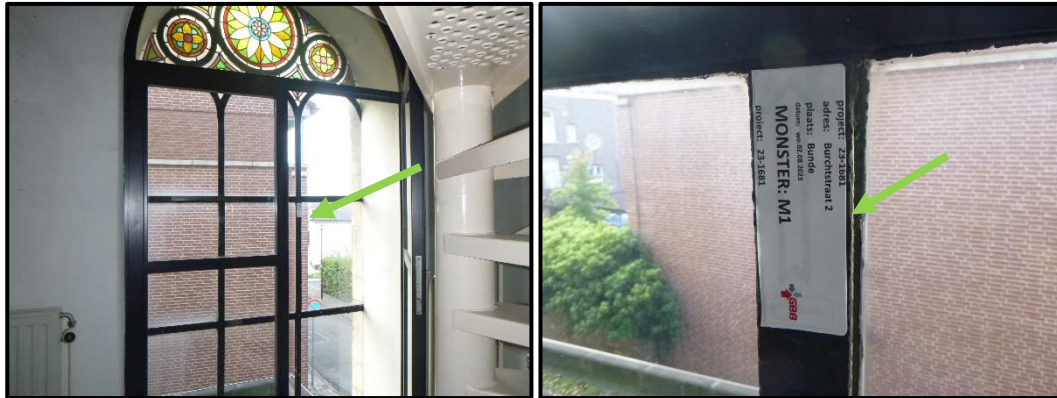
M1 – beglazingskit gevelkozijnen, niet asbesthoudend.
