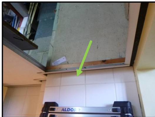
M5 – tegellijm en -voegsel wanden toiletruimte 1 e verdieping is niet asbesthoudend.
