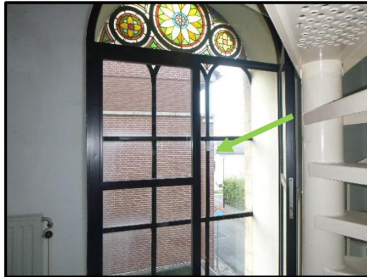
M1 – beglazingskit gevelkozijnen, niet asbesthoudend.
