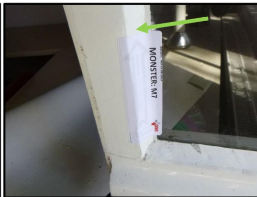
M7 – stopverf in houten gevelkozijnen, niet asbesthoudend.
