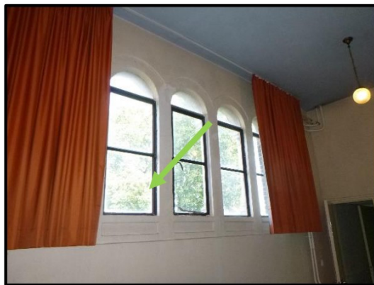
M3 – stopverf in stalen gevelkozijnen, niet asbesthoudend.
