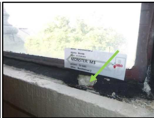
M3 – stopverf in stalen gevelkozijnen, niet asbesthoudend.
