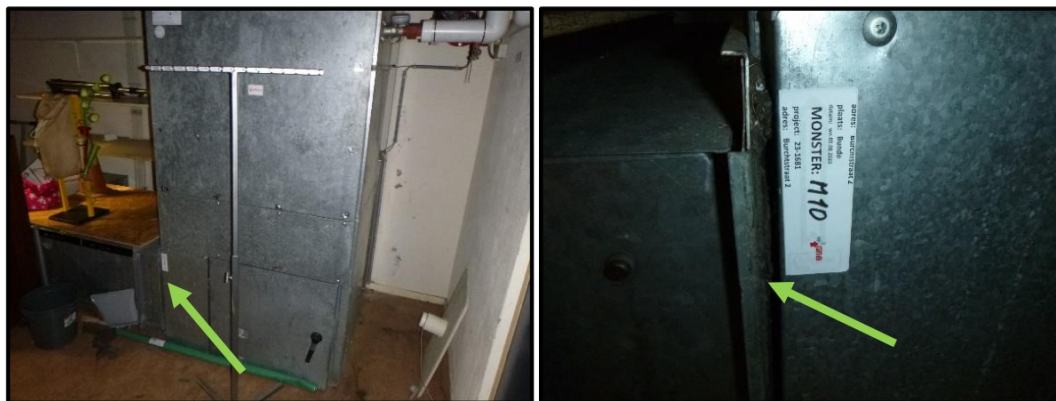
M10 – kit op luchtbehandelingskanalen, niet asbesthoudend.
