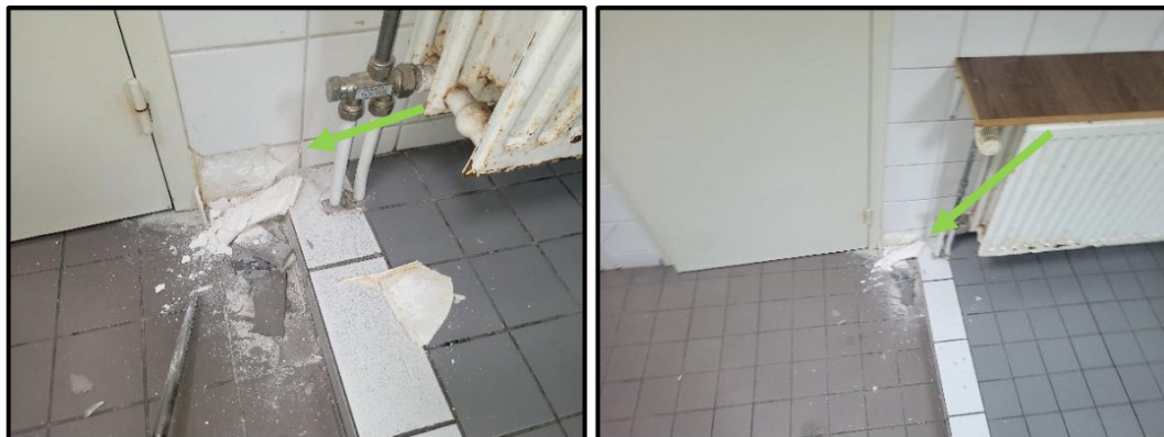
M11 – tegellijm en -voegsel wanden toilet begane grond is niet asbesthoudend.
