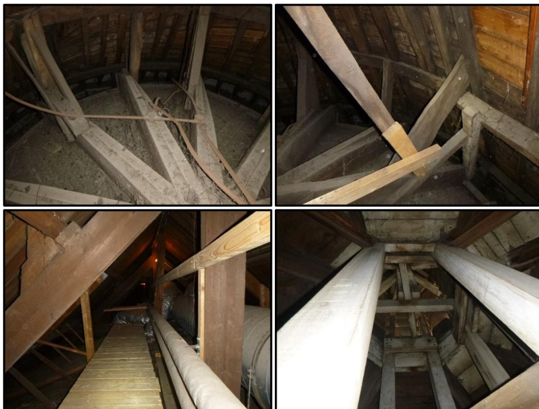
Onderzoeker heeft onderzoek uitgevoerd aan dakconstructies, hierbij zijn geen asbestverdachte toepassingen aangetroffen.
