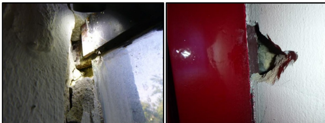
Onderzoeker heeft destructief onderzoek uitgevoerd aan kozijnaansluitingen in buitengevels, hierbij zijn geen asbestverdachte toepassingen aangetroffen.
