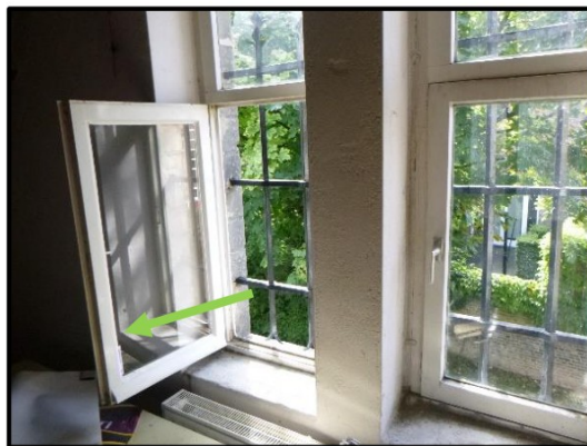
M7 – stopverf in houten gevelkozijnen, niet asbesthoudend.
