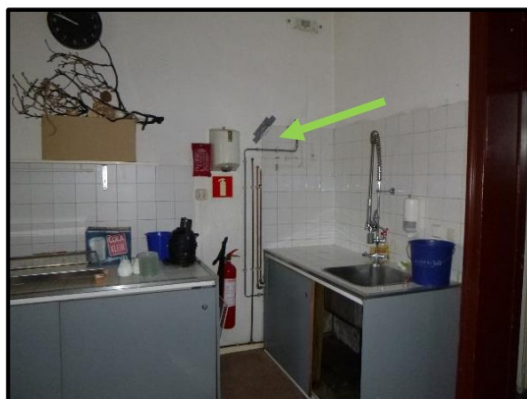
M8 – tegellijm en -voegsel wanden keuken begane grond is niet asbesthoudend.
