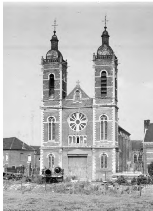
Afbeelding 18 De kerk omstreeks 1971, na sluiting voor de eredienst. De entreepartij is verwijderd en vervangen door een garagepoort (bron: Beeldbank RCE)
