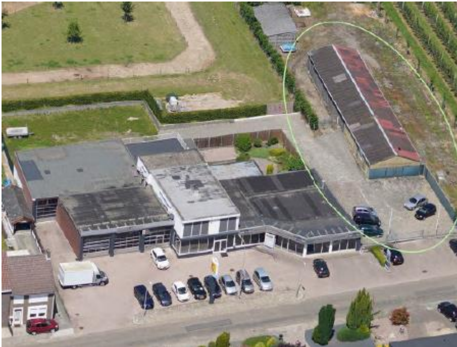
Figuur 1.3 Bestaande bebouwing
