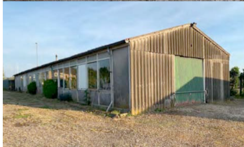
fotos aanwezig bebouwing
