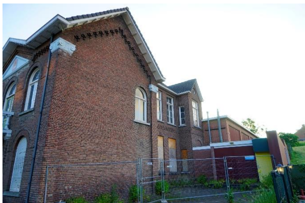
Noordzijde van het pand.
