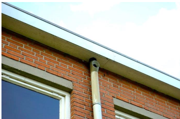
Detailfoto van een regenpijp aan de zuidzijde.
