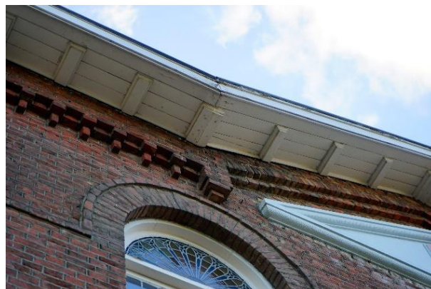
Detailfoto van de dakrand aan de oostzijde.
