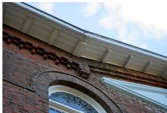
Detailfoto van de dakrand aan de oostzijde.
