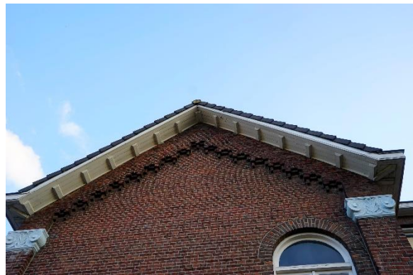
Detailfoto van de noordelijke dakrand.
