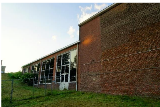
Zuidzijde van het pand met aanbouw.
