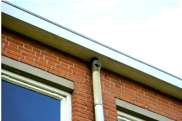
Detailfoto van een regenpijp aan de zuidzijde.
