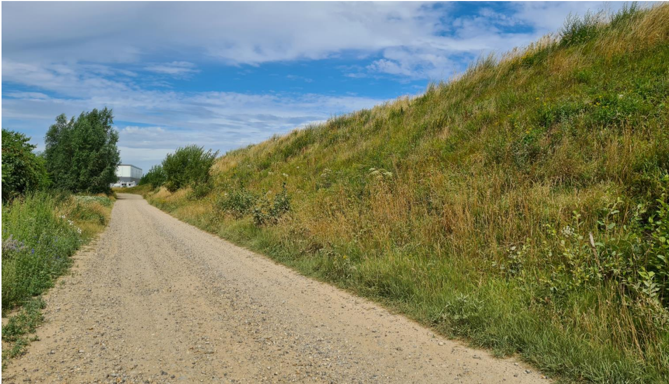
Figuur 4: Noordelijke gedeelte van Waselderweg bestaande uit een zandpad en naastgelegen zandwal
