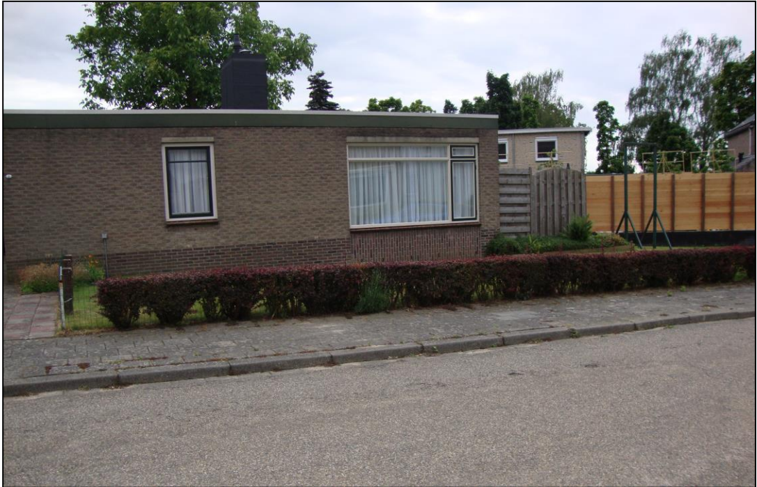
De tegenover het plangebied gelegen woning
