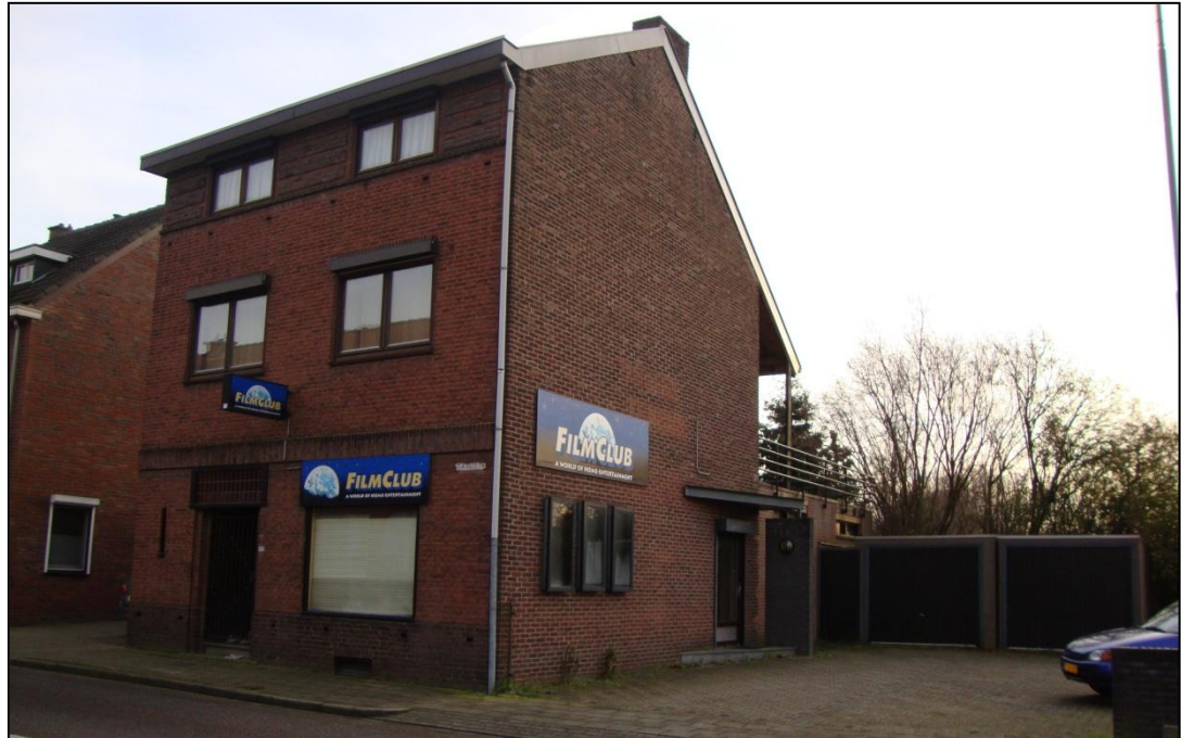
De voor- en linkerzijgevel van het pand, met ten westen van het pand (op de foto rechts) de bijbehorende garage units
