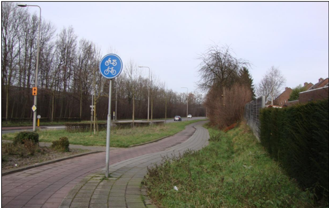
De Maastrichterweg (met langsliggend fietspad) in noordelijke richting
