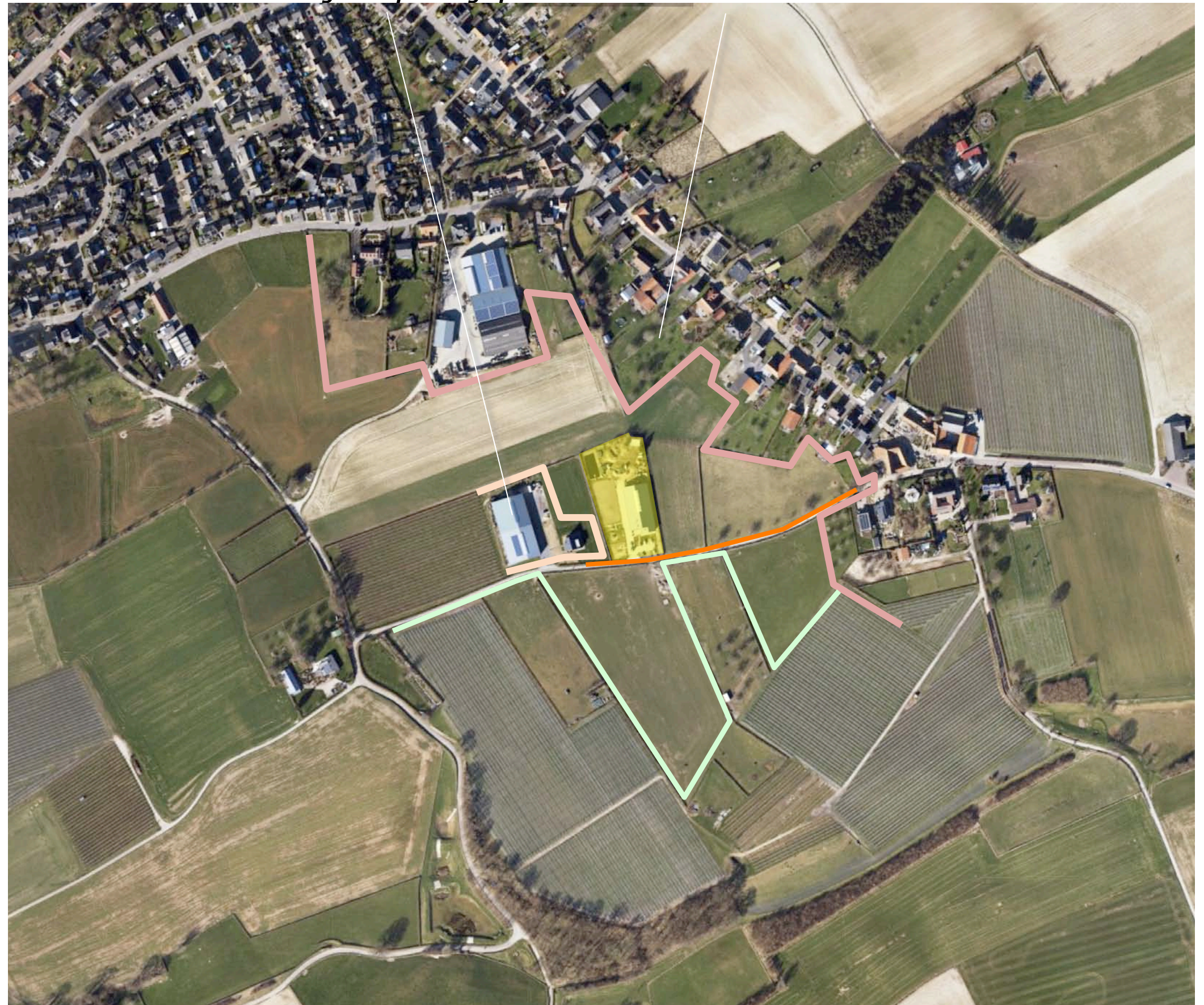
bebouwing en beplanting op het buurerf en van de kern Ulestraten
