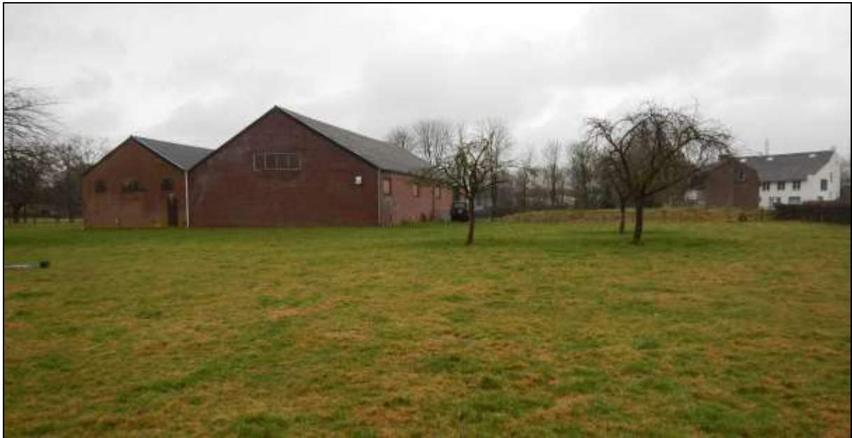
Figuur 21: Plangebied nabij boring 1, gezien in noordoostelijke richting
