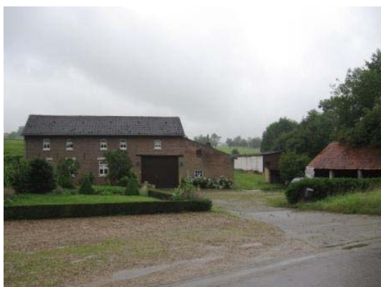
Figuur 3: Het onderzoeksgebied gezien vanaf de wegwant.
