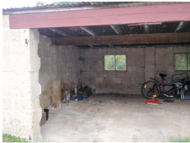
Foto 10: De locatie van de vml. opslag van bestrijdingsmiddelen (garage).
