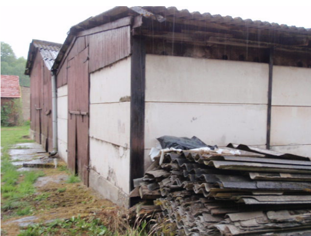
Foto 7: Aan de rechterzijde van de veestal zijn de boringen voor de huidige afgewerkte olie opslag verricht. Tevens zijn hier asbestplaten opgeslagen.
