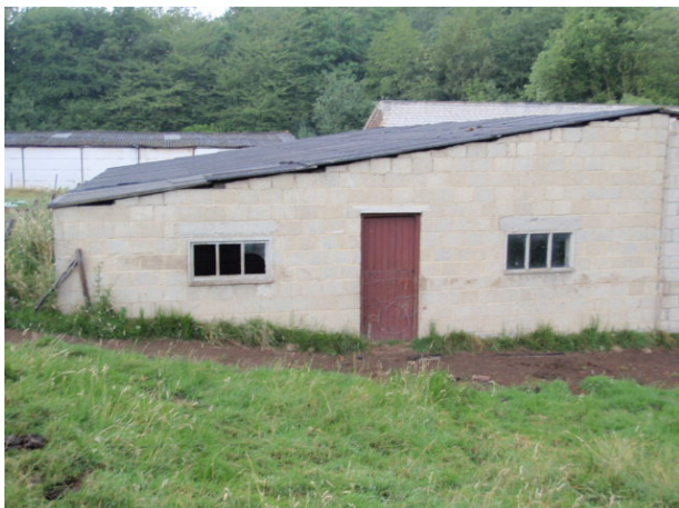
Foto 9: Locatie bovengrondse olietank (1.200 L) volgens Hinderwet tekening van 1988.
