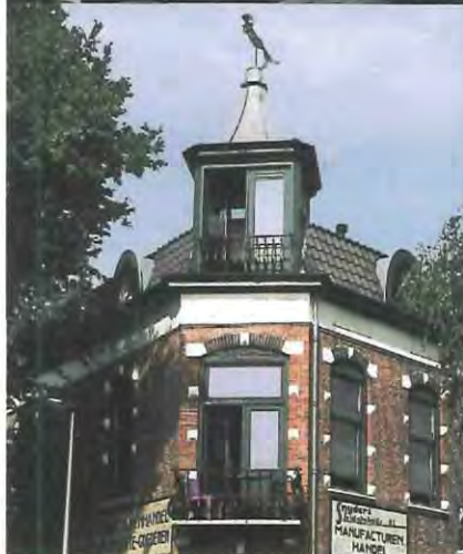
Ter verkrijging van extra leerruimte zijn op dit schoolgebouw dakkapellen op twee niveaus geplaatst. Er is gestreefd naar een traditionele oplossing, die zich tijdelijk voegt naar de architectuur van de school, ook al doet hun forse volume afbreuk aan het gesloten dakvlak zoals dat bij een school gebruikelijk is (foto Jolie Kalmijn)
