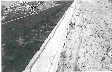
Foto 9 Beton muur en losse zand / aarde
