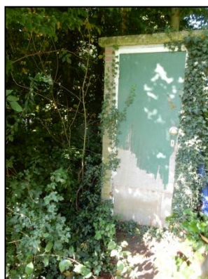
Figuur 7. Klein gebouw in de noordwesthoek van de onderzoekslocatie.
