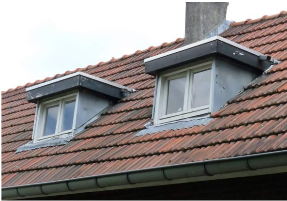
Fig. 5. Detail dakkapellen, met geschikte openingen voor vleermuizen
